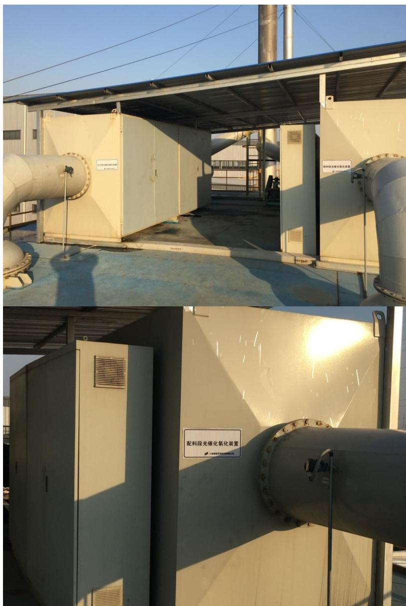
图 4.1.2-2 排气筒废气治理设施图片（光催化氧化箱）
